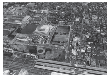
建設前のサンプラザ周辺。当時、高い建物はほとんどありませんでした
